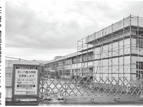
人件費や物価高騰等により、解体費用も年々増加している。
