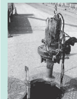
マンホールポンプの引き上げ作業の様子
