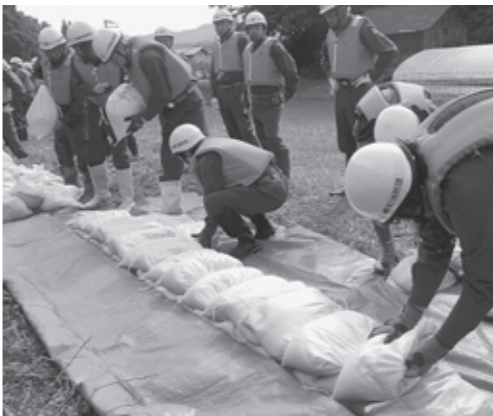
積み土のう工法を実施
