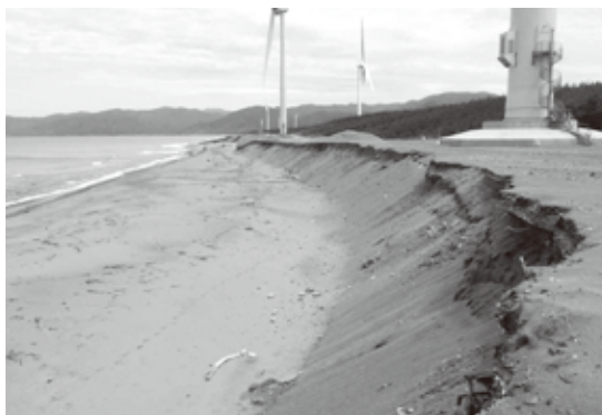
浸食が進んでいる高野々海岸線
