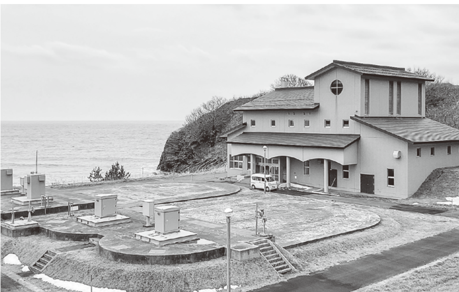
生活排水等を浄化処理する八森浄化センター
