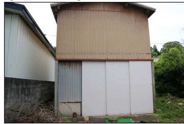
【小屋】 (撮影日) 令和4年8月15日
