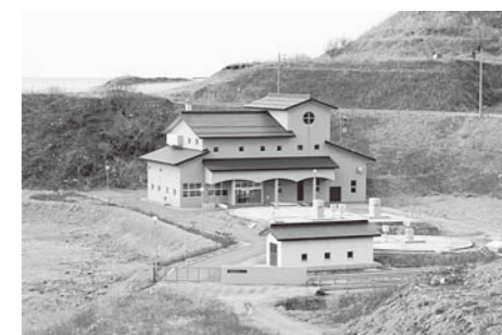
海岸近くに建設されている八森浄化センター
