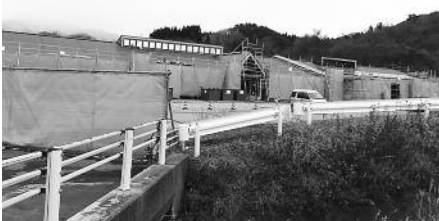
現在建設中の子ども園 (平成25年12月撮影)
