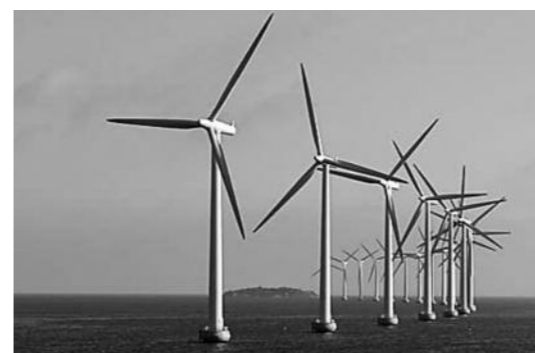
洋上風力発電(銚子市)
