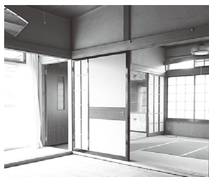
石川地区空き家改修前
