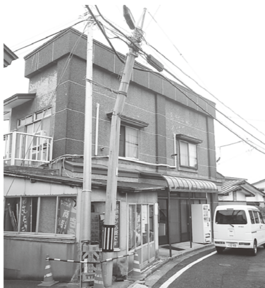
災害で腐食し折れた電柱
