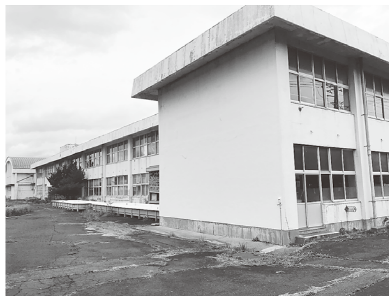
除却(解体)が予定される旧八森校舎
