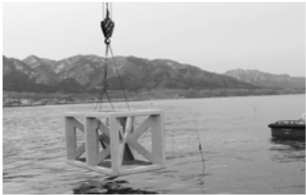
次々とブロックが沈められました
