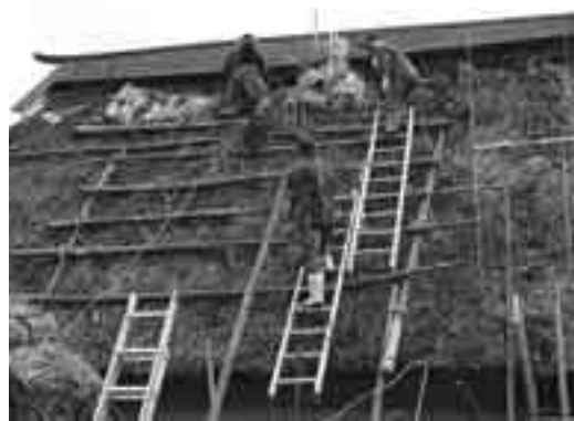
かやぶき屋根の補修風景
