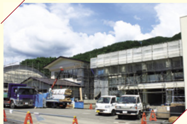
夏休みに入り急ピッチに進む改修工事
