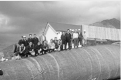
惜しまれながらも、平成2年に煙突が解体
