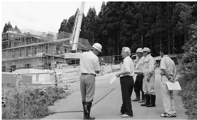
観海浄水場の現地調査の様子
