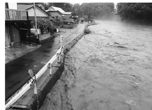
真瀬川の水位も上がり氾濫寸前に
