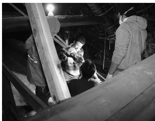
古民家の屋根裏で作業する参加者
