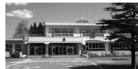
旧埴川小学校校舎
