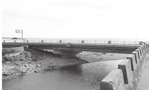
日見橋橋梁改良事業
