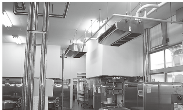
給食センター空調機新設事業
