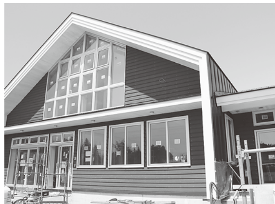
現在建設中の峰浜ボンポコ子ども園
