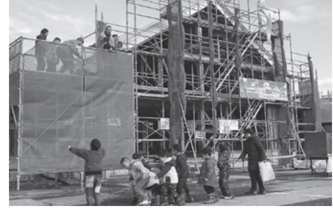
工事の安全を祈願しました
