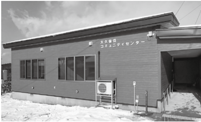
新設された大久保岱コミュニティセンター
